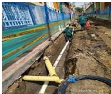
Estado de avance
