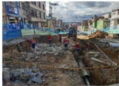
Estado de avance
